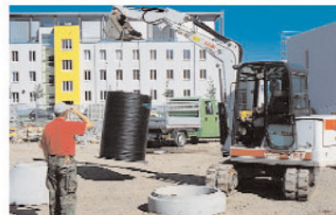
Mise en place du corps avec un mini tractopelle.
