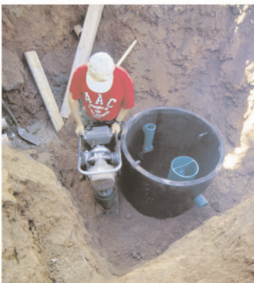
Remplissage de la fosse.
