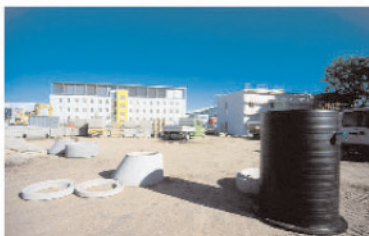
Livraison sur chantier.
