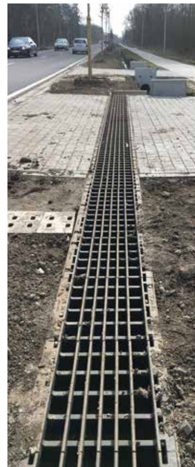
Montage in een grindpad
