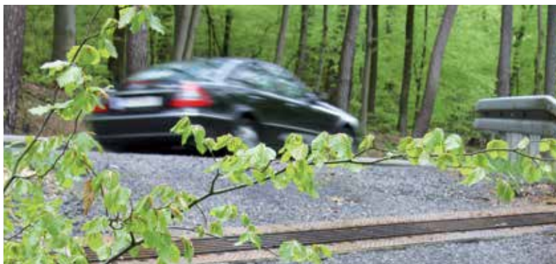
Roosterkanaal in een zijweg met steile helling
