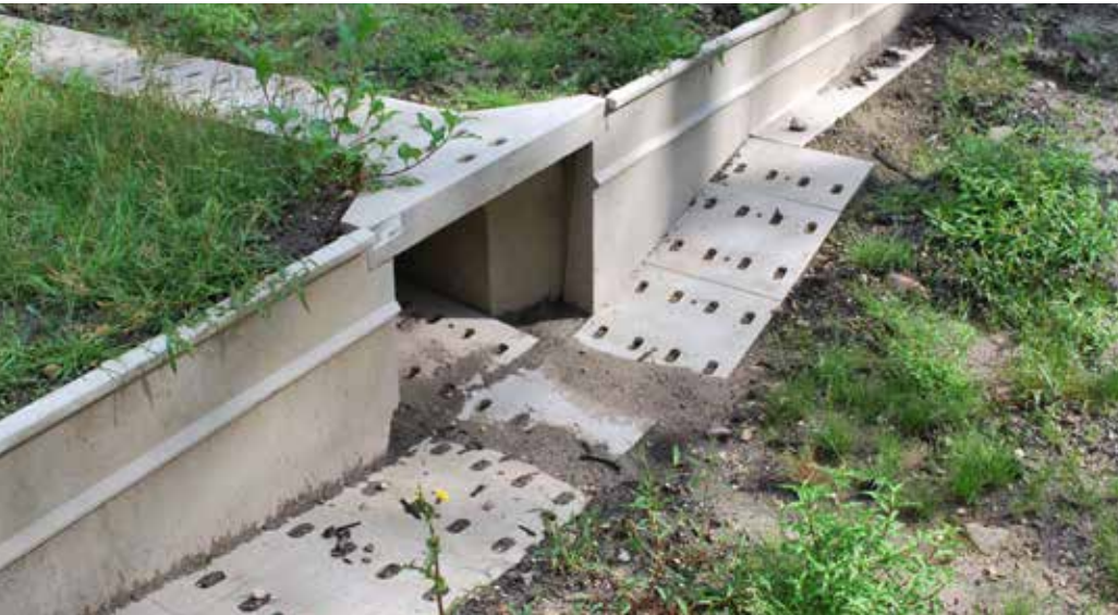
Klimaattunnel KT 500, ingangselement KP 1000-700, geleidingswand LEP 100
