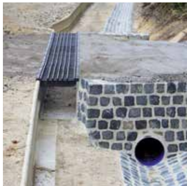
Speciale oplossing: gescheiden waterafvoer
