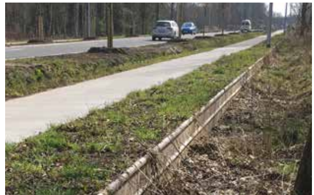
Installatie in de berm
