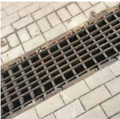
Roosterkanaal aangestraat met tegels
