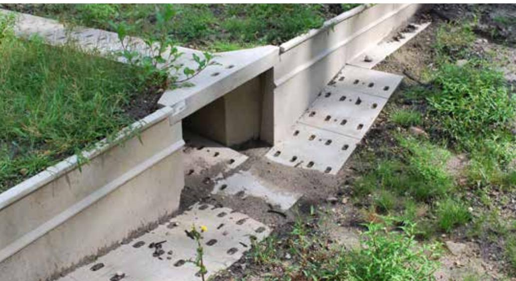
Tunnel climatique KT 500, élément d'entrée KP 1000-700, paroi guide LEP 100
