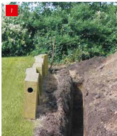
1 La pose est un jeu d'enfant. Il vous suffit de creuser une tranchée avec la bêche ou une mini-excavatrice.
