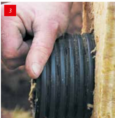
3 Système d'emboîtement pratique ! Sortez la conduite de passage de 6 cm à l'avant de chaque bloc pour effectuer facilement tous les raccordements.
