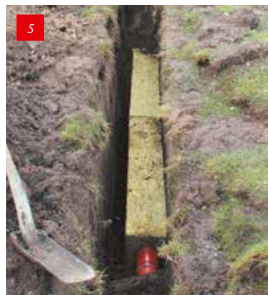
Zijn de blokken correct verbonden, vul dan laagsgewijs op met de weggegraven grond. Wel niet aanvullen met te vaste kleigrond!
