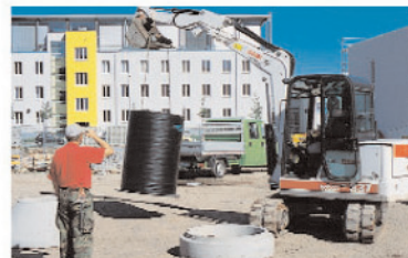
Plaatsing van het lichaam met een mini-tractopelle.
