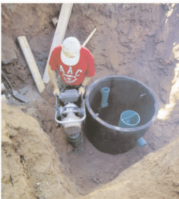
Vullen van de kuil.
