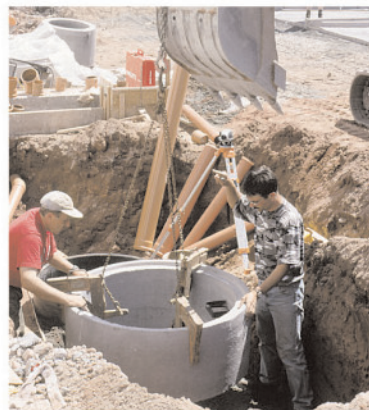
Plaatsing van het betonnen topelement.
