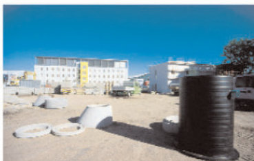
Levering op het bouwterrein.
