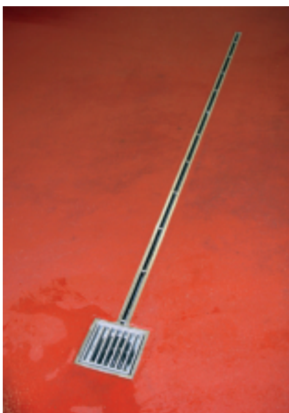
In de zouterij en afdeling vleesverwerking werd zo'n twintig meter aan sleufkanalen geïnstalleerd.
