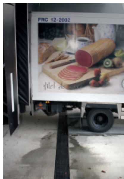
Aan het tankstation en los-/laadkaden werden kanalen uit polyesterbeton met gietijzeren roosters geïnstalleerd.
