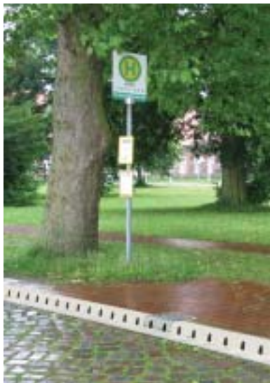
Trottoirband en afwatering uit één stuk, ACO DRAIN® KerbDrain®.
