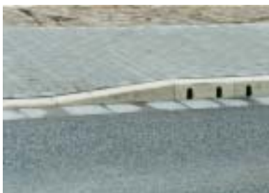
ACO DRAIN® KerbDrain® met aflopende stenen voor perceeloppitten.
