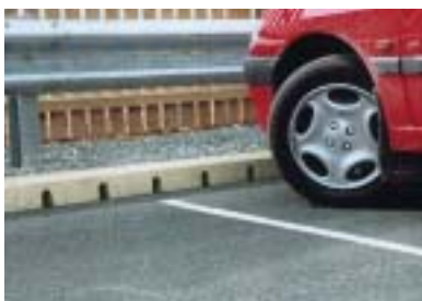
ACO DRAIN® KerbDrain® op parkeerplaatsen.
