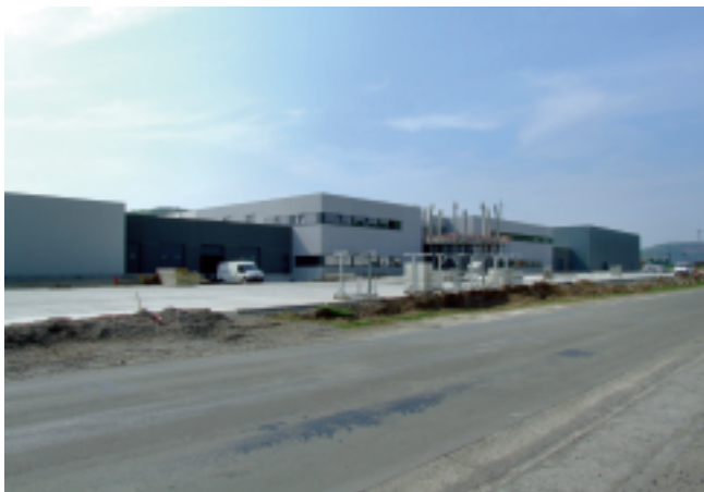
Afin de consolider la croissance annuelle de trente pour cent, Père Olive construit depuis mai 2006 une toute nouvelle usine de 22.000 m 2 .
