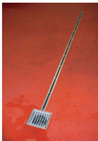
Dans le saloir et dans la section de transformation de viande ont été installés quelque vingt mètres de canaux en tranchées.
