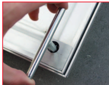
Ensuite utiliser les clés pour soulever le couvercle
